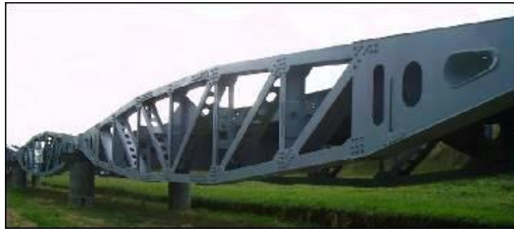
Naast het museum in Arromanches is een enkel wegdek segment ('Whale') te vinden De afgebeelde is er één van meerdere segmenten te vinden in Vierville-sur-Mer
