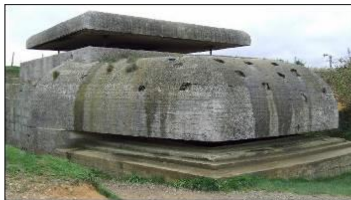
Leitstand M 262, de vuurgeleidingsbunker
