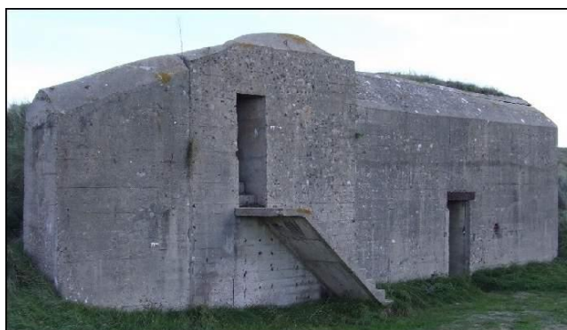
Eén van de drie H655 bunkers even voorbij Exit-3
